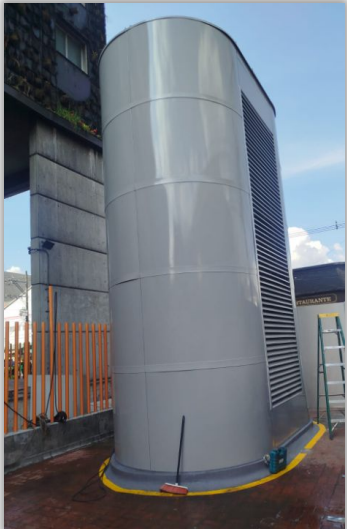
Desmante e Instalación de nueva chimenea para plantas de emergencia por incendio ocurrido
