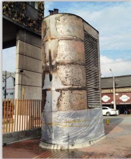
Desmante e Instalación de nueva chimenea para plantas de emergencia por incendio ocurrido
